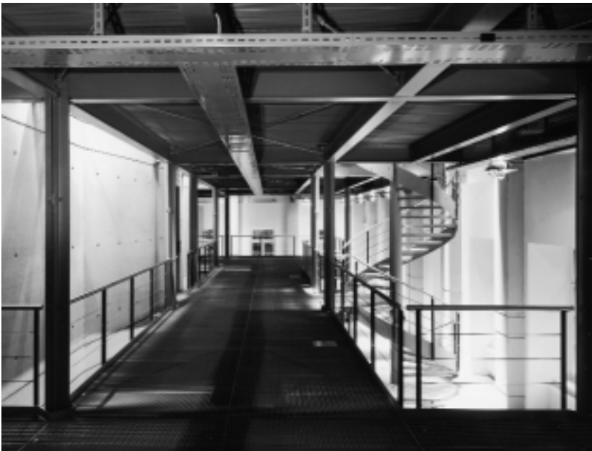
Zürichbergstrasse 4: Innenaufnahme – die berühmten Gitterroste.
