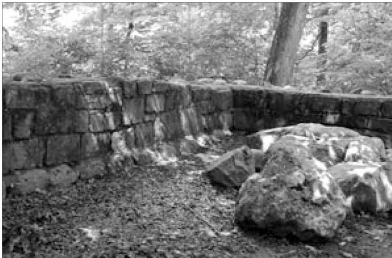
Abb. 11: Aktuelle Innenansicht an die nordwestliche Ecke der inneren Ringmauer. Die beiden Mauern stehen heute miteinander im Verband. Foto vom 9. Juli 2005.
